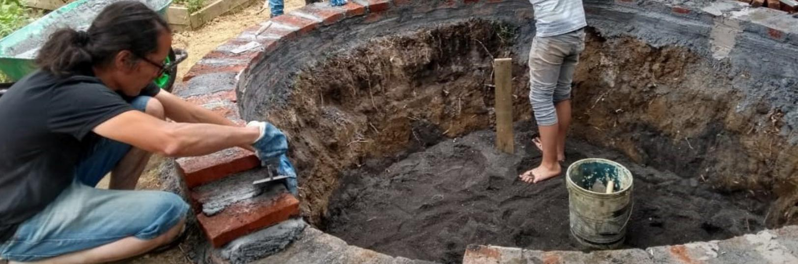
Fig. 2: Construcción del Lombrifiltro. Fuente: Entorno educador del Valle de Nonguén.
